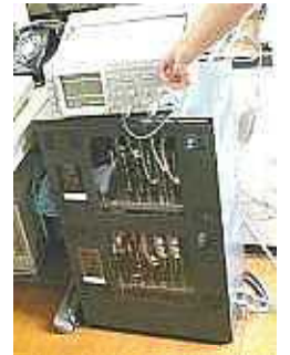
電話交換機実習装置
