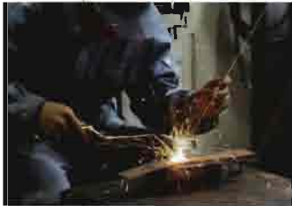
酸素・アセチレンガスの炎や電気の火花(アーク)を用いて鋼板などを溶接します。
